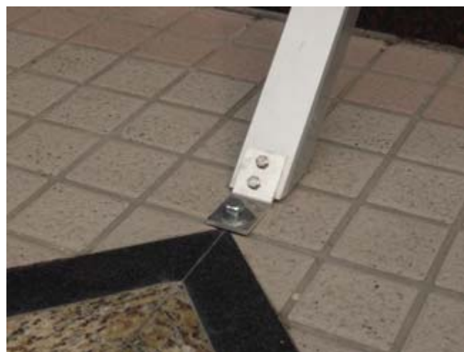
4. 將中柱斜撐，以四分螺絲固定於 後地平螺栓孔內。
