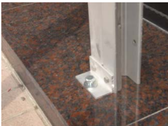
2. 將中柱以四分螺絲 固定於前地平螺栓孔。
