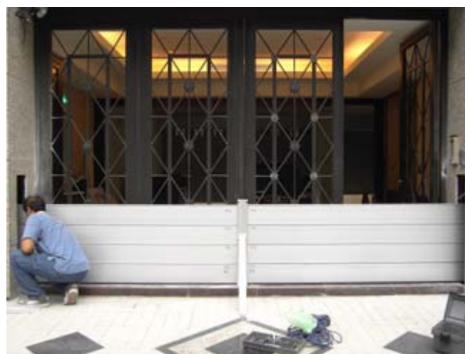
6. 擋水板安裝後完成圖。
