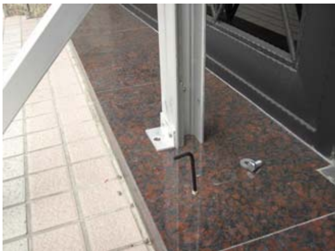
1. 前地平螺栓內止付螺絲， 以內六角扳手拆除。
